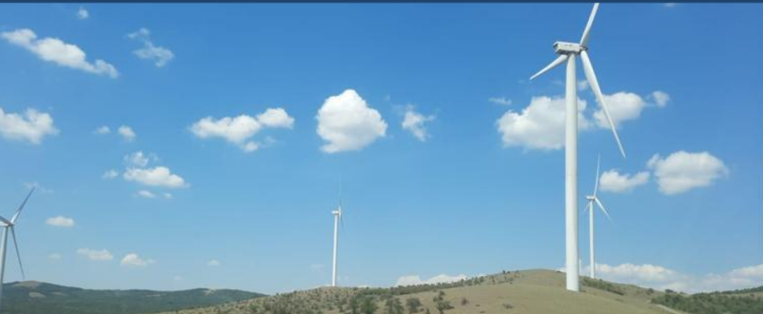
Parcul eolian de 13,75 MW al Premier Energy din Nalbant, județul Tulcea, România, unde un proiect suplimentar de 13,75 MW se află în prezent în dezvoltare.
