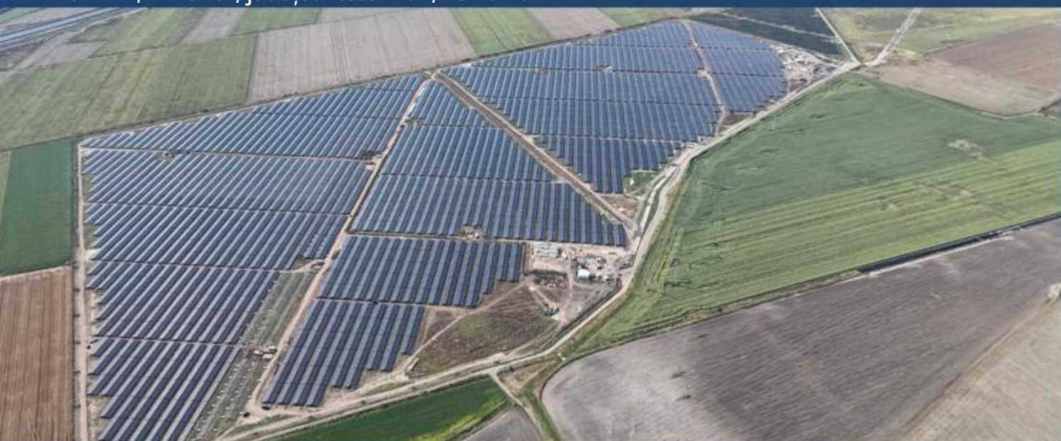
Parcul solar de 48 MW al Premier Energy, cu o capacitate de stocare în baterii de 16 MWh, în Stâlpu, județul Buzău România.
