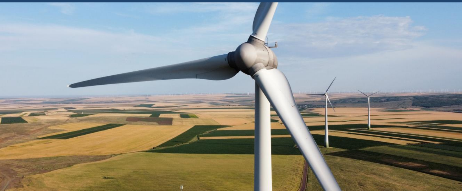
Parcul eolian de 80 MW al Premier Energy din Mihai Viteazu, județul Constanța, România.
