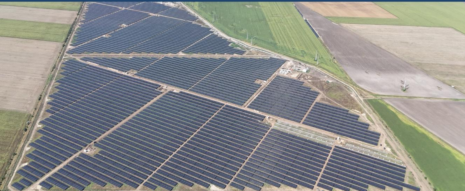
Parcul solar de 63 MW al Premier Energy, cu o capacitate de stocare în baterii de 20 MW în construcție, județul Buzău, România
