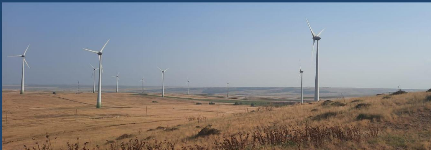
Parcul eolian de 34,5 MW al Premier Energy, Stejaru, județul Tulcea, România
