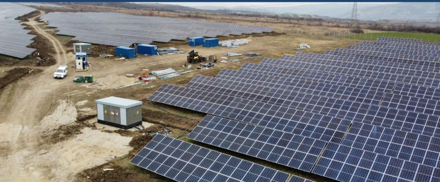
Parcul solar CEF Izvoru Barzii de 14,8 MW, județul Mehedinți, România, administrat de Premier Energy
