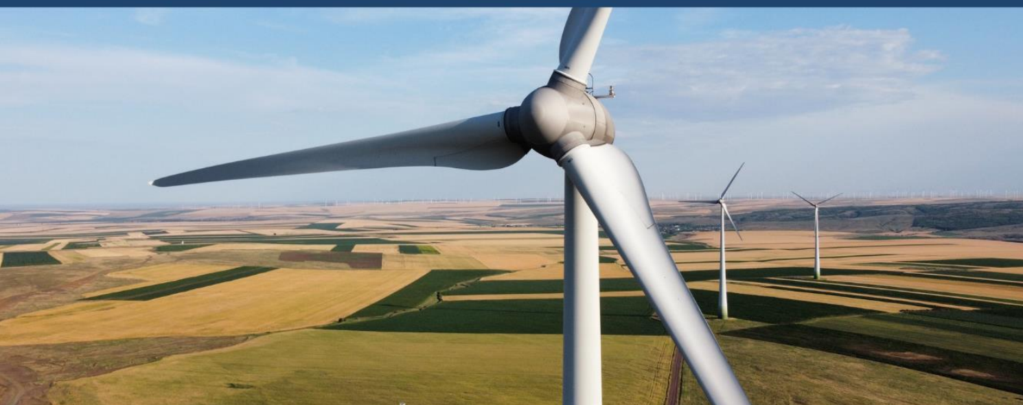
Parcul eolian de 80 MW al Premier Energy, Mihai Viteazu, județul Constanța, România
